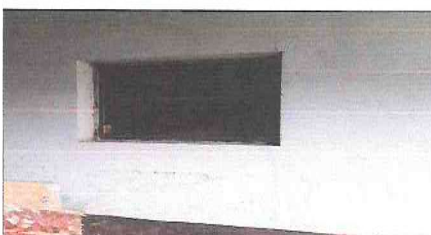
Foto 6: Remodelar ventanas de 1.5x2
