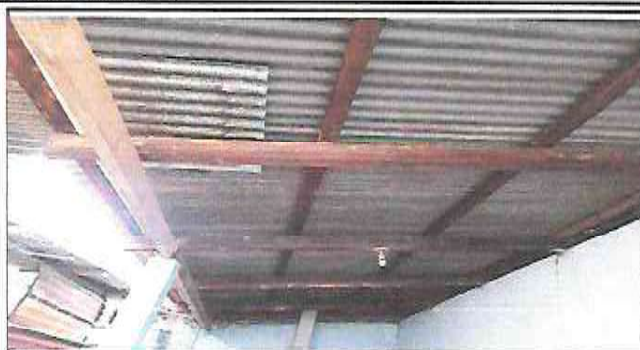
Foto1: Cambio de lámina troquelada alucin calibre 26 y cambio de estructura metálica.
