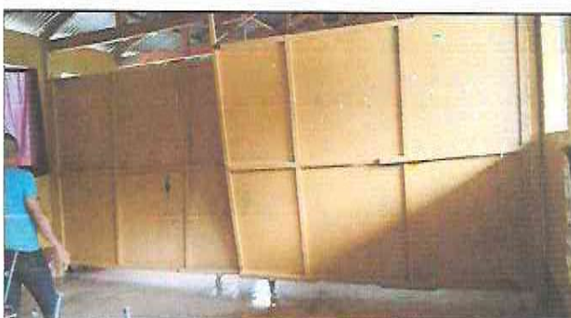
Foto 4: Fabricar división con madera tratada y Pivvloo de 1/2 con rodos
