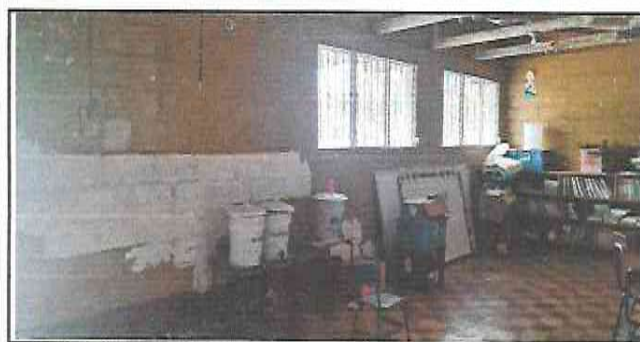
Foto 5: Pintura general aulas, baños y cocina
