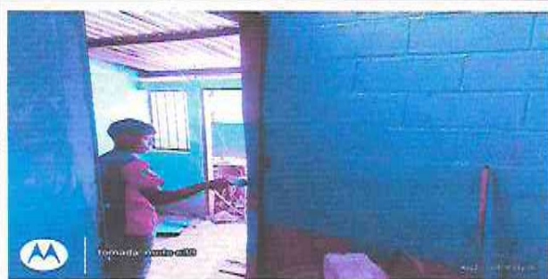
PINTURA EN EXTERIOR E INTERIOR EN AULAS
