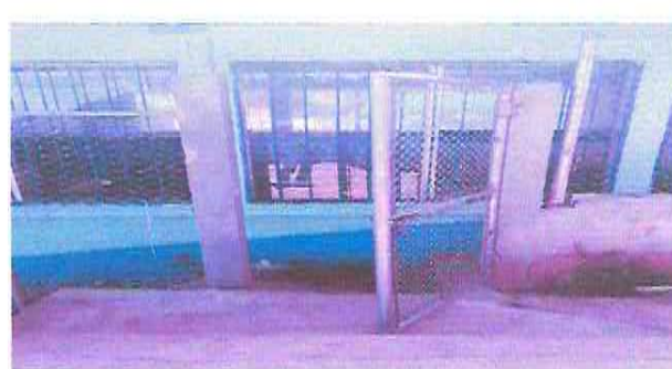
SUSTITUCION DE MADERA POR PUERTA DE MADERA Y TUBO GALVANIZADO
