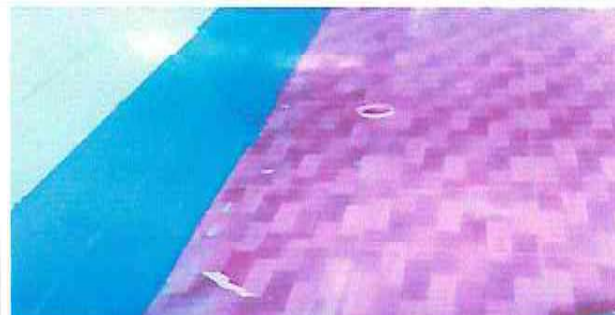
SUSTITUCION DE PISO LIQUIDO POR PISO CERAMICO
