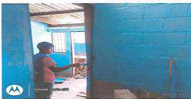
PINTURA EN EXTERIOR E INTERIOR EN AULAS
