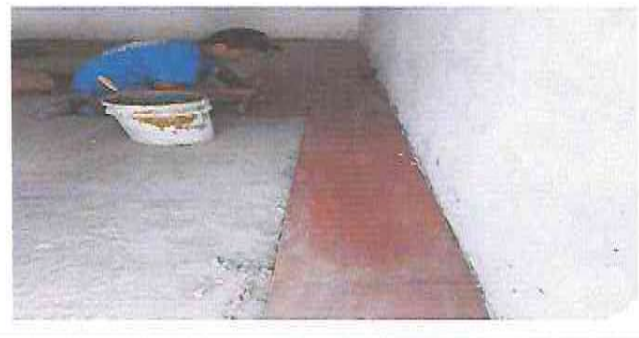
SUSTITUCION DE PISO LIQUIDO POR PISO CERAMICO
