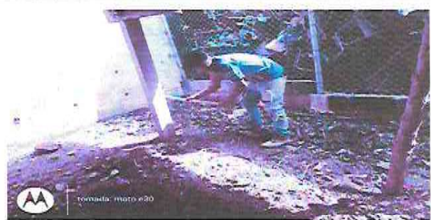
REPACION DE TORTA DE CEMENTO EN PATIO
