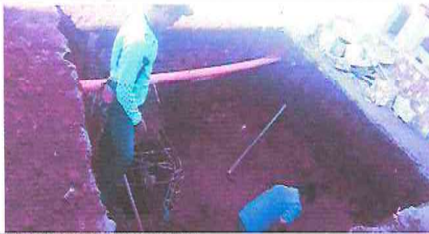
SUSTITUCION DE FOSA SEPTICA
