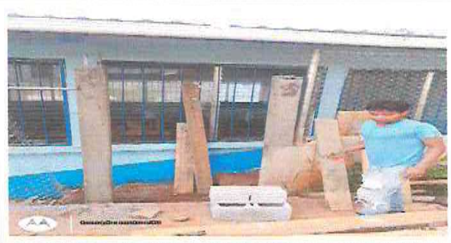
SUSTITUCION DE MAYA POR PUERTA DE MAYA Y TUBO GALVANIZADO
