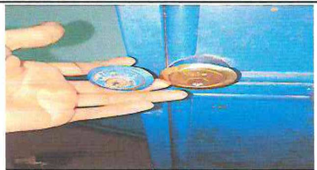
CAMBIO DE CHAPA DE PUERTA DE AULA2
