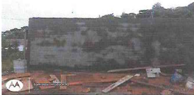
REPARACION Y REPELLO EN MURO PERIMETRAL
