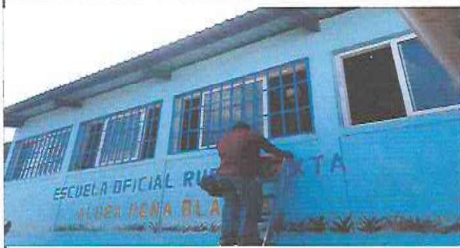
SUSTITUCION DE BALCONES DE METAL EN AULA 1
