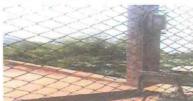
SUSTITUCION DE MAYA POR PUERTA DE METAL
