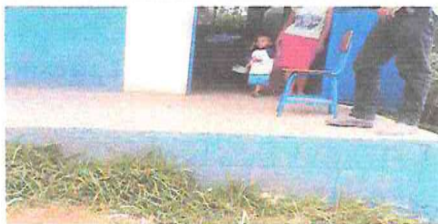
REPARACION DE MURO DE BLOCK CON TUBO Y MAYA DE METAL
