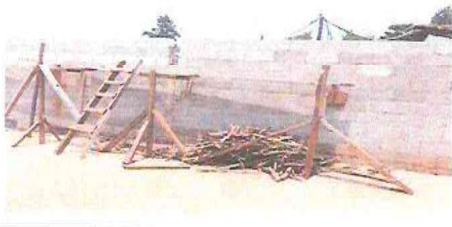
FOTO 3. REPACION Y CERNIDO EN MURO PERIMETRAL.
