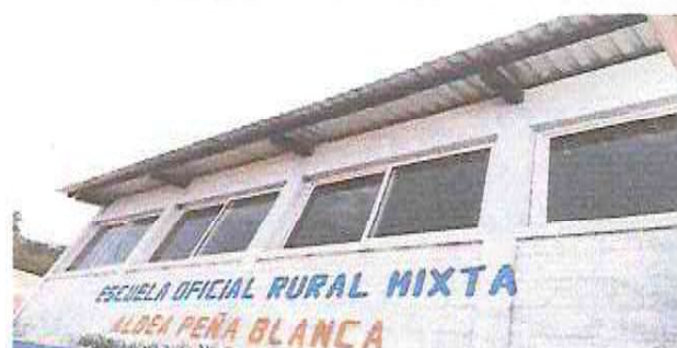
Foto 2: FABRICACION E INSTALACION DE BALCONES DE METAL EN VENTANAS.
