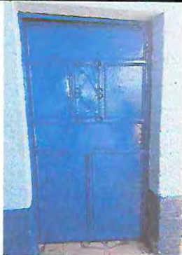
Foto 21: Mantenimiento lijado, cepillado y pintura a puerta
