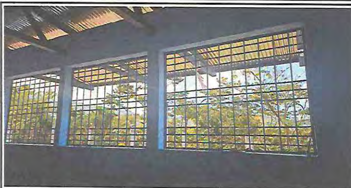
Foto 19: Mantenimiento a balcones con pintura
