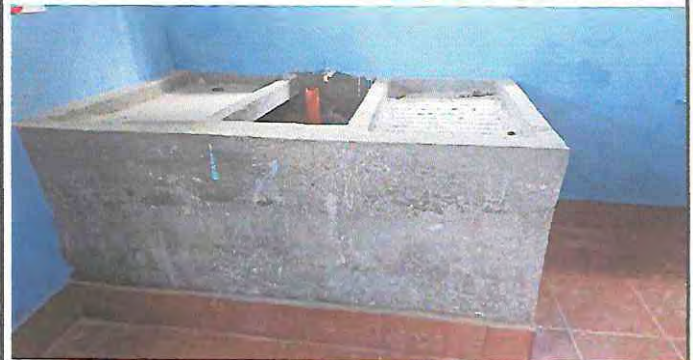
Foto 8: Sustrucción de pila con dos lavaderos
