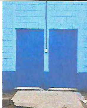
Foto 16: Mantenimiento con pintura y cambio de chapa
