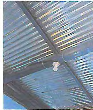
Foto 14: Sustitución de electricidad 2 bombillas y 2 apagadores sencillos
