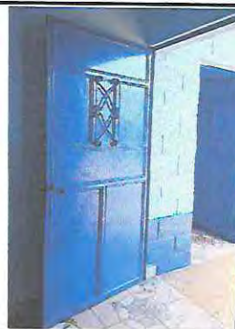
Foto 18: Sustitución de puerta de metal 2.15 x 1.00
