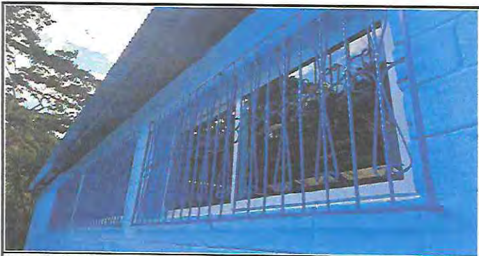
Foto 17: Sustitución de ventanas de madera por ventana PVC 2.40 x 1.00 Mantenimiento con pintura a balcones
