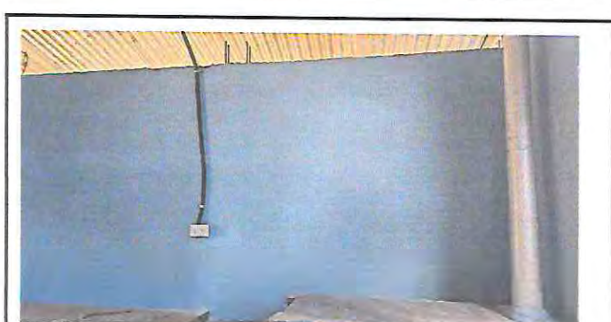
Foto 6: Mejoramiento de electricidad
