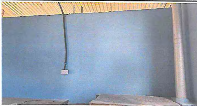
Foto 9: Mejoramiento de paredes con repello y cernido
