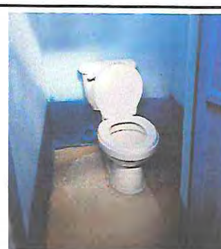
Foto 12: Sustrucción de sanitarios y suministros
