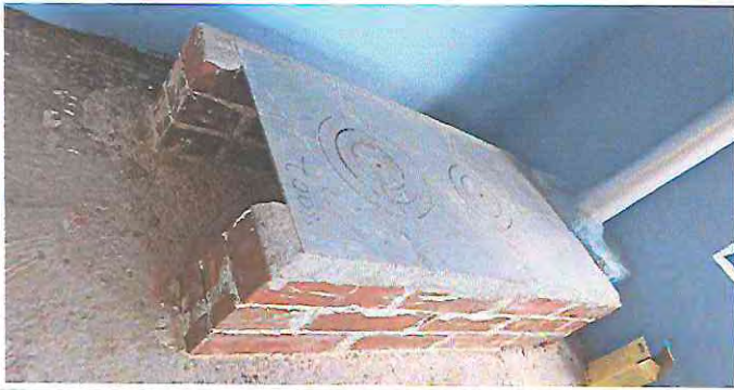
Foto 7: Sustrucción de estufa rural con plancha y chimenea
