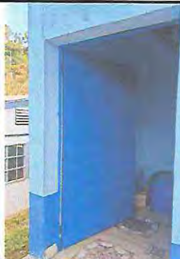
Foto 20: Mantenimiento con pintura a puerta
