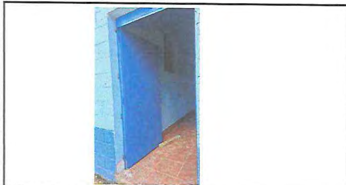
Foto 3: Sustitución de puerta 1.00 x 2.15
