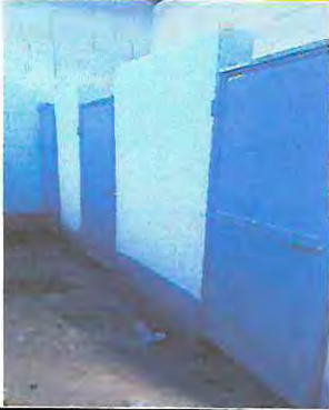
Foto 13: Mantenimiento lijado, cepillado y pintura a puertas
