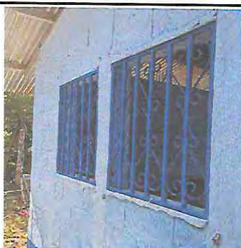
Foto 11: sustitución de balcón por balcón de metal 1.00 x 1.00
