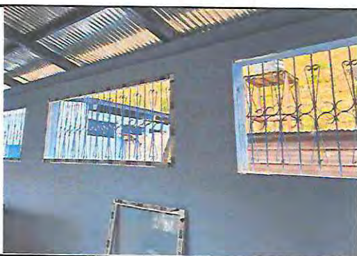
Foto 17: sustitución de ventanas de madera por ventanas PVC 2.40 x 1.00 mantenimiento con pintura a balcones
