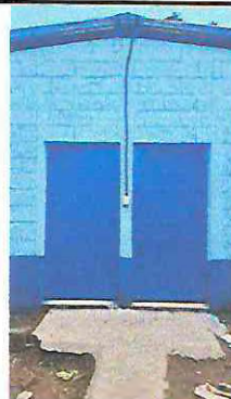
Foto 16: mantenimiento con pintura y cambio de chapa
