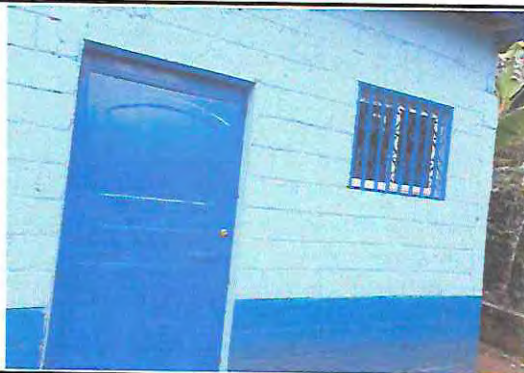
Foto 3: sustitución de puerta 1.00 x 2.15
