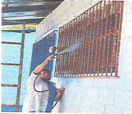
Foto19: mantenimiento a balcones con pintura
