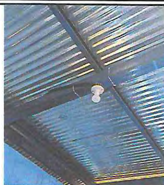
Foto 14: sustitución de electricidad 2 bombillas y 2 apagadores sencillos
