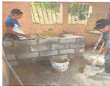
Foto 8: sustitución de pila con dos lavaderos
