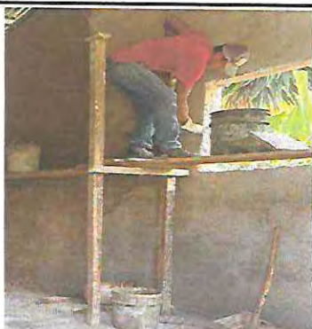
Foto 9: mejaramiento de paredes con repello y cernido
