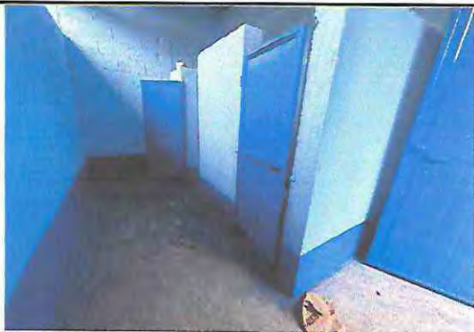
Foto13: mantenimiento lijado, cepillado y pintura a puertas
