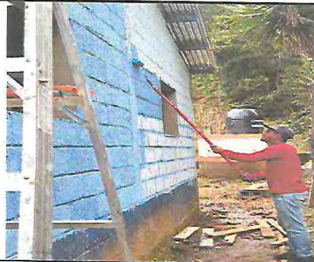
Foto 22: pintura en muros interiores y exteriores (baños, aulas, cocina y dirección)
