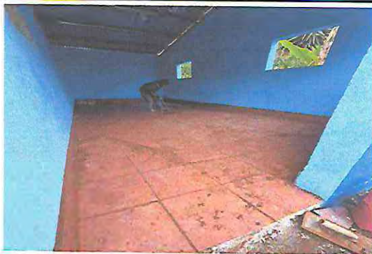
Foto1: mejoramiento del piso de aula 3 por piso cerámico
