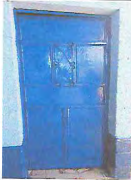
Foto 21: mantenimiento lijado, cepillado y pintura a puerta
