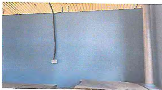
Foto 6: mejoramiento de electricidad
