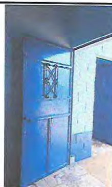
Foto 18: sustitución de puerta de metal 2.15 x 1.00
