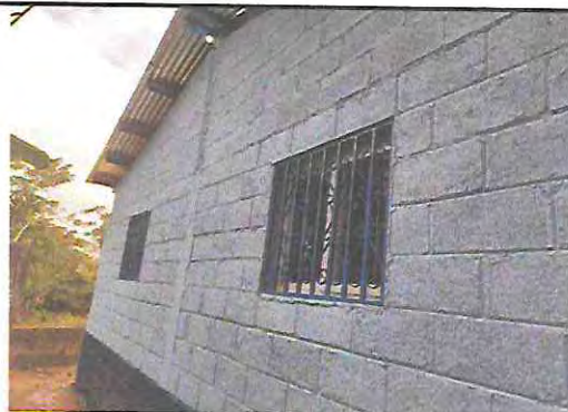
Foto 4: sustitución de balcones de madera, por balcones de metal
