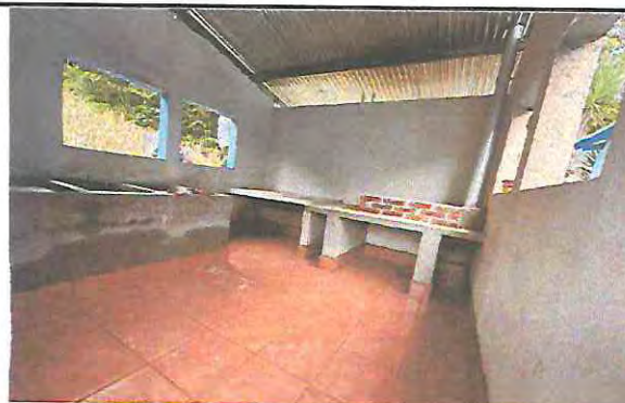
Foto 10: sustitución de piso por piso cerámico
