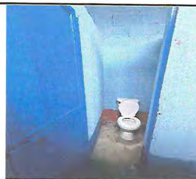
Foto 12: sustitución de sanitario y suministros
