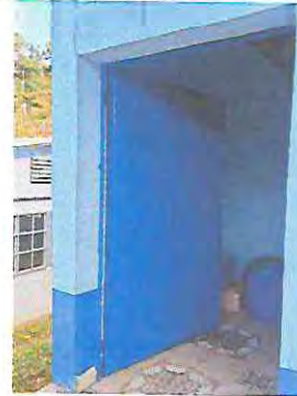
Foto 20: mantenimiento con pintura a puerta
