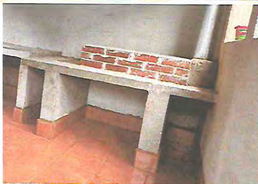
Foto 7: sustitución de pila con dos lavaderos
