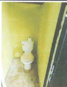
Foto 5: Baños Sustitución de sanitarios y suministros
