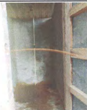
Foto 3: Reparación de loza por loza de cemento
