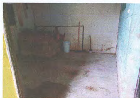
Foto 4: Pintar muros interiores y exteriores
