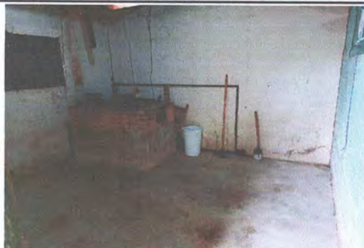
Foto1: Sustitución de piso por piso cerámico
