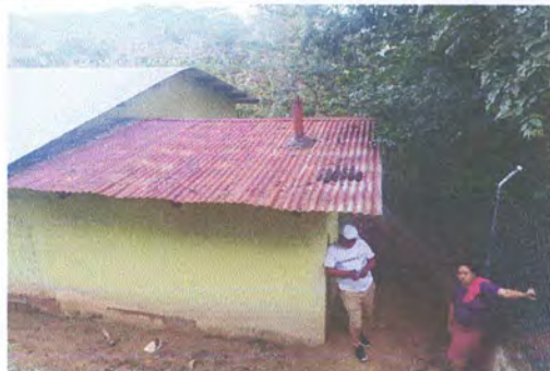
Foto 1: Sustrucción de lámina por lámina troquelada scalibre 26
