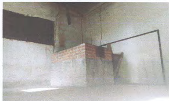
Foto 2: Sustitución de polletón, plancha y chimenea
