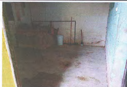
Foto 2: Sustitución de piso por piso cerámico
