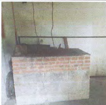
Foto 1: Sustitución de polletón, plancha y chimenea
