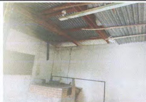
Foto 6: Sustitución de estructura de madera por estructura metálica
