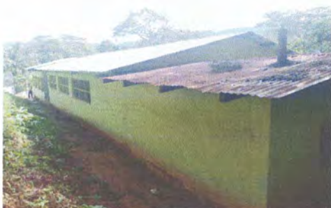
Foto 3: Pintar muros interiores y exteriores
