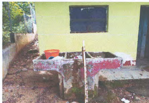
Foto 4: Sustitución de pila movable por pila fija
