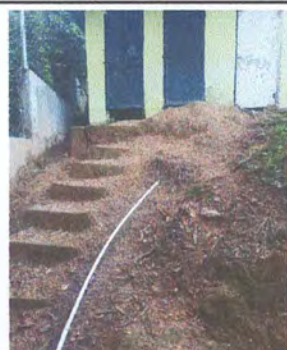
Foto 5: Sustrucción de gradas por gradas de concreto acceso a baños
