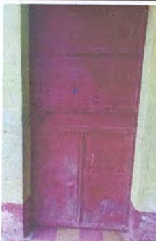
Foto 1: Mantenimiento de puerta lijada y pintada
