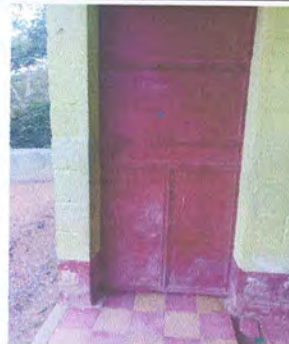
Foto 2: Mantenimiento de puerta lijada y pintada
