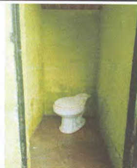
Foto 6: Baños Sustitución de sanitarios y suministros
