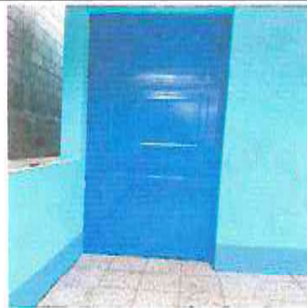
FOTO 2: SUSTITUCIÓN DE PUERTA.
