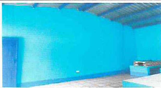
FOTO 1: REMODELACIÓN DE PARED DE BLOCK.
