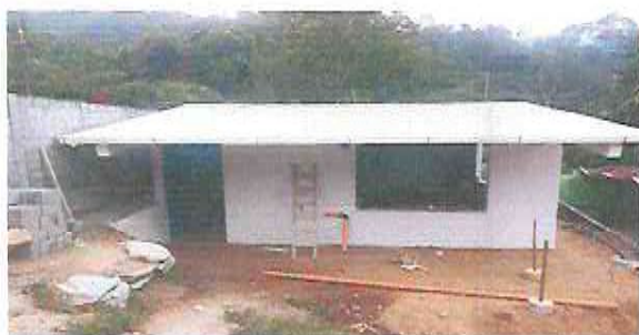
FOTO 3: SUSTITUCIÓN DE ESTRUCTURA DE METAL DE VENTANA A PVC.
