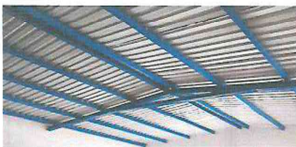
FOTO 5: PINTURA EN MUROS EXTERIORES E INTERIORES.
