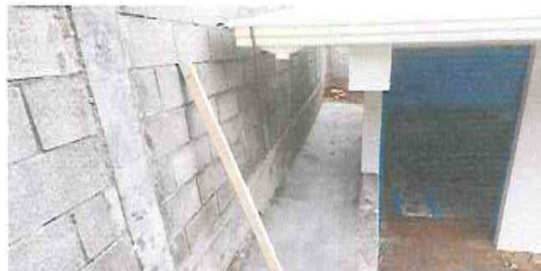
FOTO 4: SUSTITUCIÓN DE PISO DE GRANITO.
