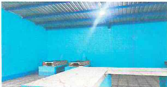
FOTO 5: PINTURA EN MUROS EXTERIORES E INTERIORES.
