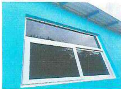
FOTO 3: SUSTITUCIÓN DE ESTRUCTURA DE METAL DE VENTANA A PVC.
