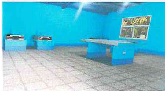
FOTO 4: SUSTITUCIÓN DE PISO DE GRANITO.
