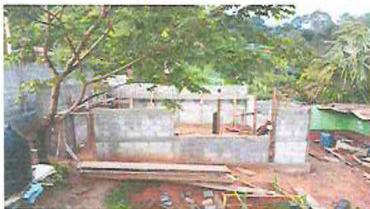
FOTO 1: REMODELACIÓN DE PARED DE BLOCK.
