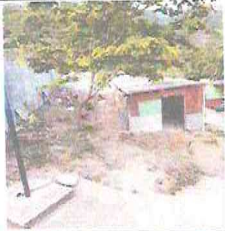
FOTO 1: REMODELACIÓN DE PARED DE BLOCK.
