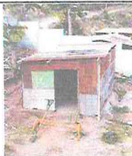
FOTO 5: PINTURA EN MUROS EXTERIORES E INTERIORES.
