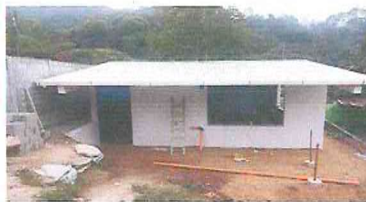
FOTO 2: SUSTITUCIÓN DE PUERTA.
