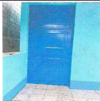
FOTO 2: SUSTITUCIÓN DE PUERTA.
