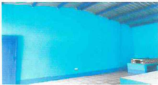
FOTO 1: REMODELACIÓN DE PARED DE BLOCK.
