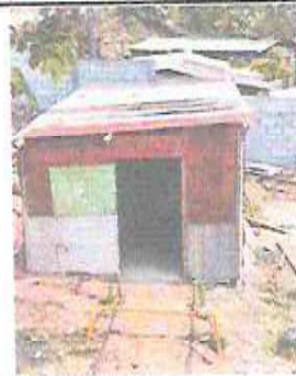
FOTO 2: SUSTITUCIÓN DE PUERTA.
