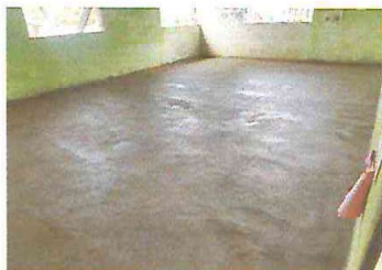
Foto 1: el piso ya finalizado
