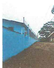
Foto 4: malla completamente instalada muro con cernido con pintura dentro y fuera del muro
