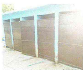
Foto 2: puertas de los baños ya con su remozamiento
