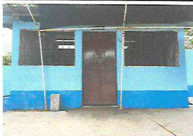
Foto 3: puerta de la cocina ya en buen estado
