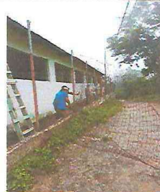
Foto 4: inicio de cambio de malla en el muro perimetral
