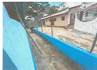
Foto 6: inicio de pintura en muros y pared
