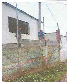
Foto 5: colocación de block en el muro en una de las partes faltantes
