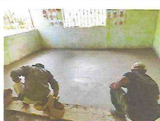
Foto 2: Se aprecia la fundición para su posterior alisado
