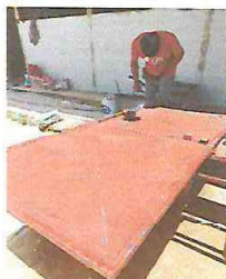
Foto 3: Se aprecia el inicio de mejoramiento de la estructura de puerta posterior la pintura
