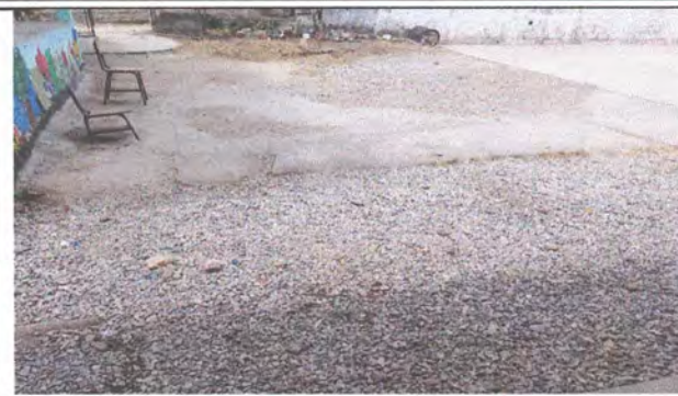
Foto 2: Mejoramiento de torta de concreto
