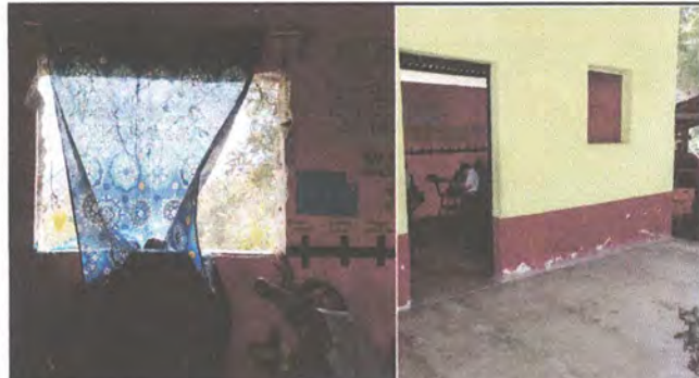
Foto 4: Sustrucción de balcon y ventana de metal por balcon de metal
