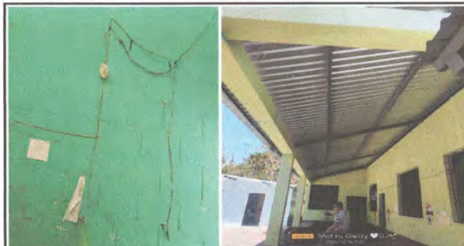
Foto 5: Mantenimiento y sustrucción del sistema electrico general
