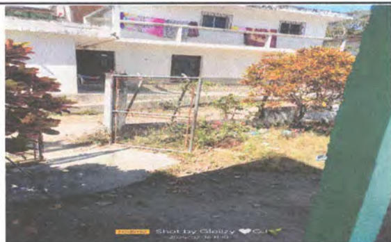
Foto 3: sustitución de porton de metal por metal
