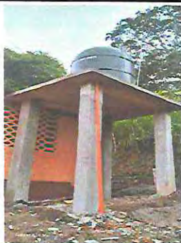
Foto 3: SUSTITUCION DE BASE DE ESTRUCTURA METALICA POR BASE DE CONCRETO PARA LA COLOCACION DE TINACO E INSTALACION DE TINACO EXISTENTE Y ACCESORIOS.
