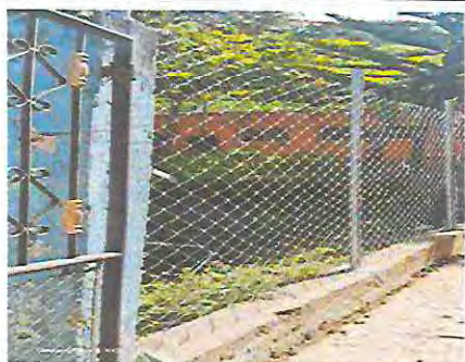
Foto 5: SUSTITUCION DE CERCADO DE MADERA CON LAMINA POR TUBO GALVANIZADO CON MAYA CICLONICA. PATIO
