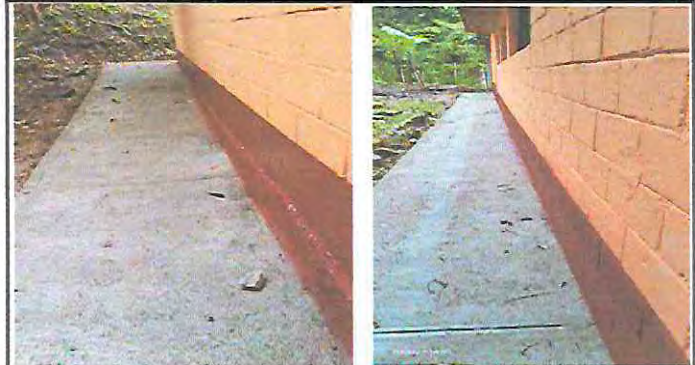
Foto 2: MEJORAMIENTO DE BANQUETA. AULA MODULO 1
