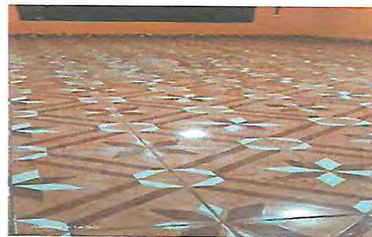
Foto 6: SUSTITUCION DE PISO, POR PISO CERAMICO. AULA MODULO 2
