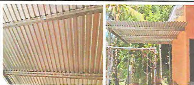
Foto 6: SUSTITUCION DE ESTRUCTURA DE MADERA POR ESTRUCTURA METALICA. AREA RECREATIVA.
