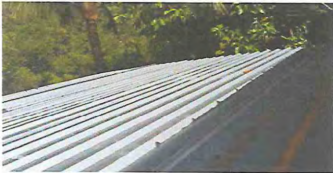
Foto1: SUSTITUCION DE LAMINA POR LAMINA TROQUELADA ALUCIN CALIBRE 26. AREA RECREATIVA.
