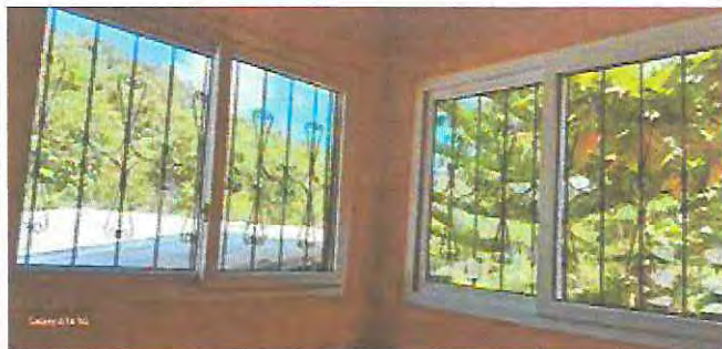
Foto 2: INSTALAR VENTANA DE PVC. COCINA
