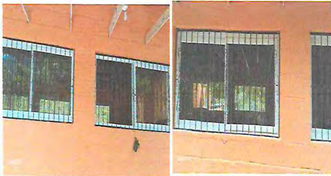
Foto1: INSTALACIÓN DE VENTANAS PVC CORREDIZAS, MANTENIMIENTO DE BALCONES. (LIJADO Y PINTADO) AULA MODULO 1
