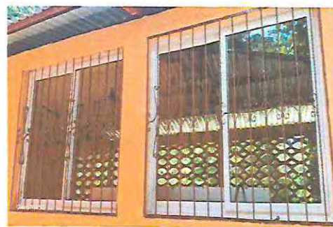
Foto 4: INSTALACION DE VENTANA PVC. AULA MODULO 2
