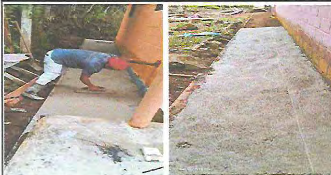
Foto 2: MEJORAMIENTO DE BANQUETA. AULA MODULO 1
