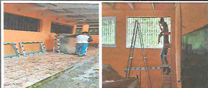
Foto1: INSTALACIÓN DE VENTANAS PVC CORREDIZAS, MANTENIMIENTO DE BALCONES. (LIJADO Y PINTADO) AULA MODULO 1
