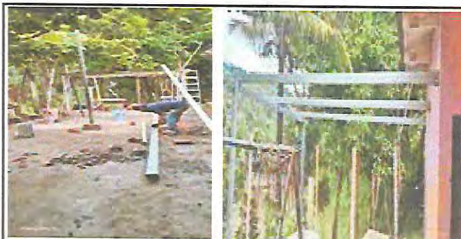
Foto 6: SUSTITUCION DE ESTRUCTURA DE MADERA POR ESTRUCTURA METALICA. AREA RECREATIVA.
