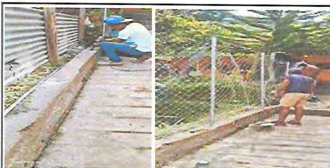
Foto 5: SUSTITUCION DE CERCADO DE MADERA CON LAMINA POR TUBO GALVANIZADO CON MAYA CICLONICA. PATIO
