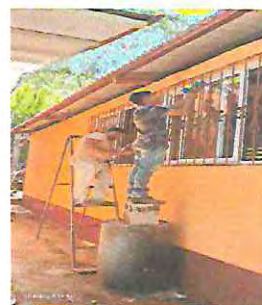
Foto 4: INSTALACION DE VENTANA PVC. AULA MODULO 2
