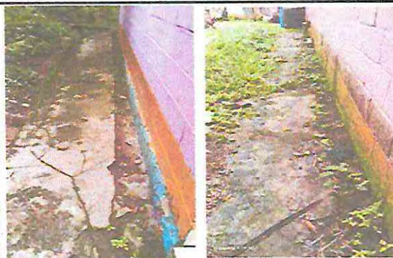
Foto 2: MEJORAMIENTO DE BANQUETA. AULA MODULO 1
