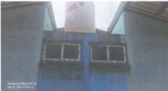
foto 11. instalaion y sustitucion de deposito de agua de 2,500lts
