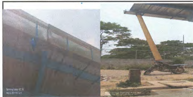
foto3. ampliacion de bajadas de agua pluvial con tubo de 3 pulgadas
