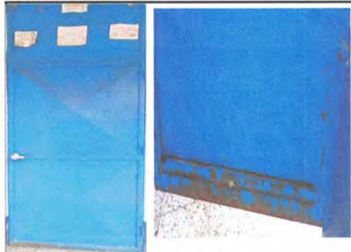
foto 1. mantenimiento a estructura (lijado, cepillado y aplicación de pintura, a 8 puertas.
