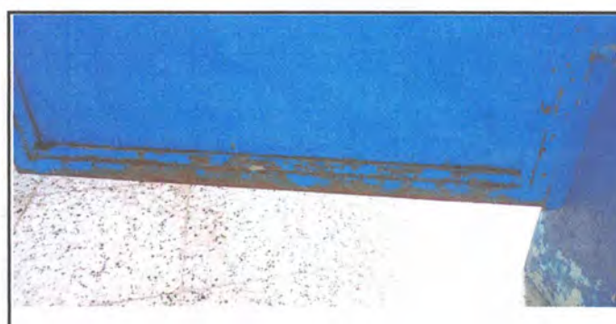
foto 6. mantenimiento a estructura (lijado, cepillado y aplicación de pintura) puerta de sanitarios
