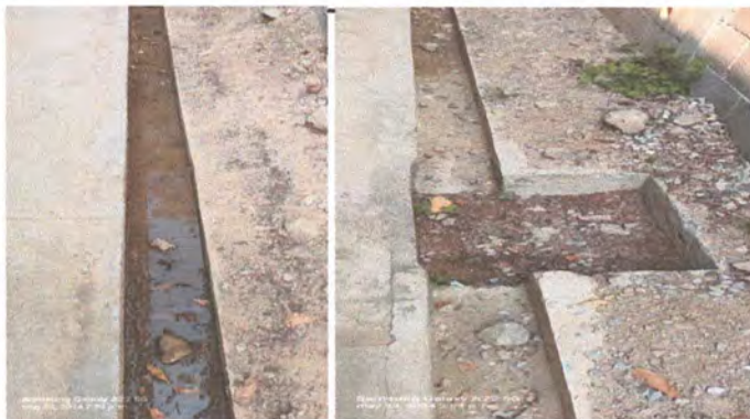
foto 4. instalacion de rejillas de metal sobre cuneta de concreto
