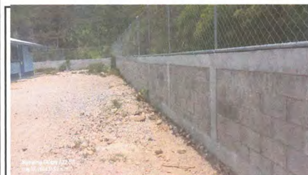
foto5.pintura en muro interiores y exteriores
