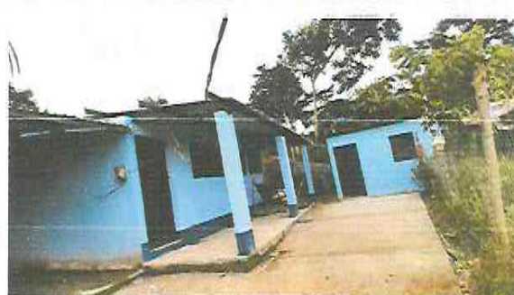
cambio de puerta de la cocina
