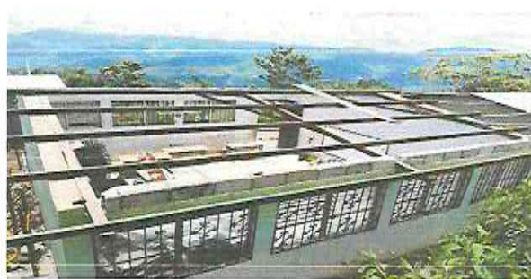
Cambio de lámina por lámina troquelada Alucín calibre 26
