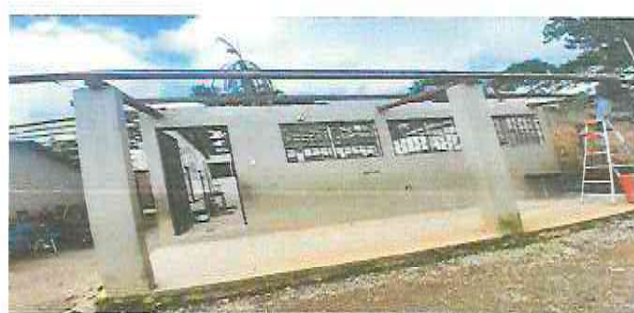
Mantenimiento de estructura metálica
