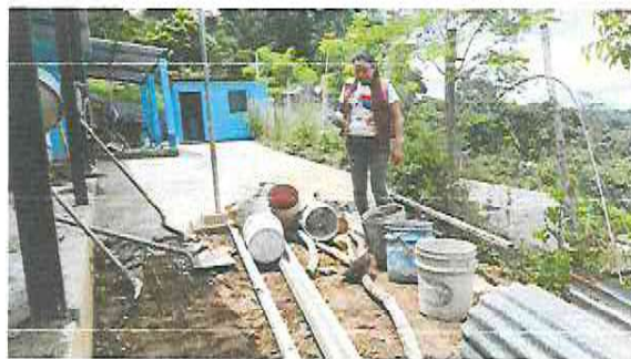
Instalación de puerta
