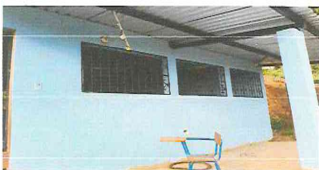
Sustitución de Ventanas
