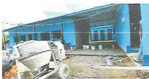
Foto 2: sustitución de torta por piso cerámico en baños
