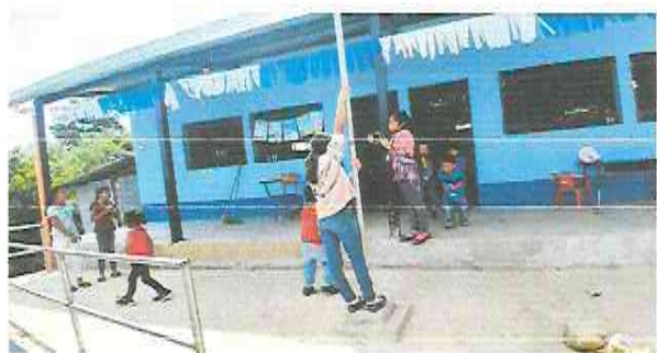
Foto 3: Reparación del sistema eléctrico
