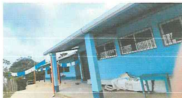
Foto 4: Instalación de canal de metal y bajada de agua pluvial. Instalación de piso cerámico.
