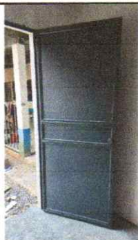
Foto 3: Puerta de cocina pintada con pintura anticorrosiva
