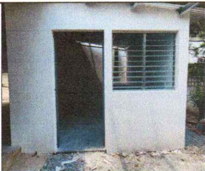
Foto 5: Cocina con ventanas y piso nuevo
