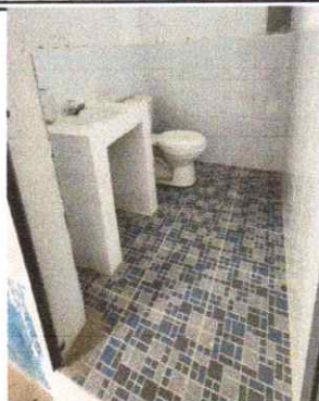
Foto 7: Primer sanitario con piso y azulejo
