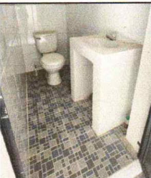
Foto 9: Segundo sanitario con su propio lavamanos y azulejos y piso nuevo
