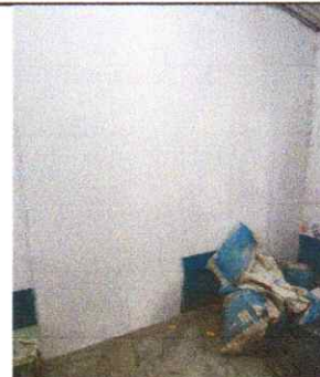
Foto 6: Cerramiento de accesos para mejorar ubicación de sanitarios
