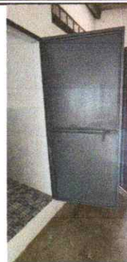
Foto 8: Puertas de ingreso al sanitario, pintadas con pintura anticorrosiva
