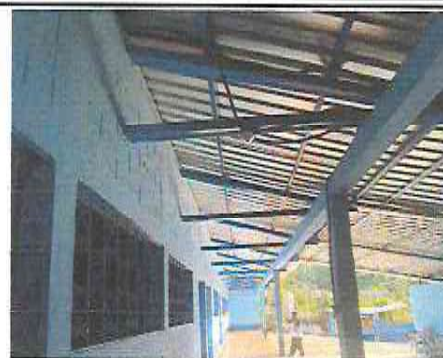
Foto 2: Mantenimiento a estructura de soporte de metal
