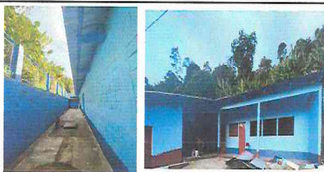
Foto 5: Pintura en muros interiores
