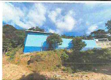
Foto 4: Pintura en muros exteriores e interiores
