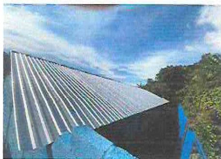
Foto1: Sustrucion de lamina por lamina troquelada aluzing calibre 26
