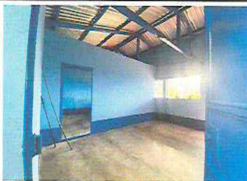
Foto 3: Instalación de Division de tabla yeso
