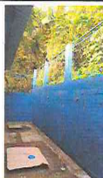
Foto 4: Pintura en muros exteriores e interiores
