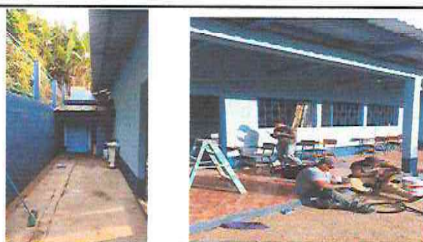
Foto 5: Pintura en muros interiores
