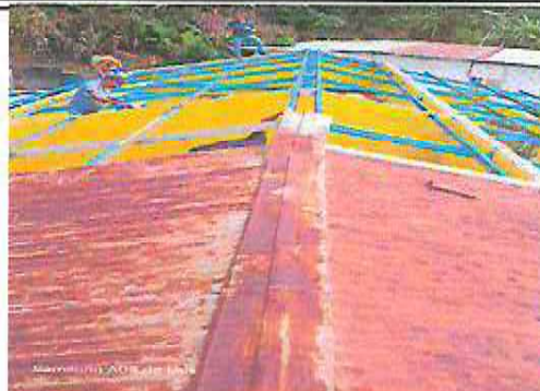
Foto 2: Mantenimiento a estructura de soporte de metal
