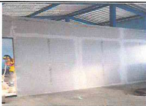
Foto 3: Instalación de Division de tabla yeso
