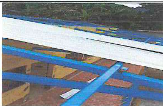
Foto1: Sustitucion de lamina por lamina troquelada aluzing calibre 26
