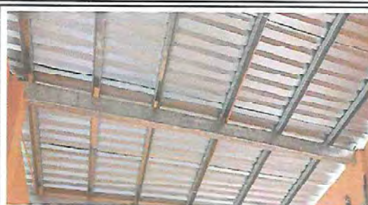
Foto 2: INSTALACIÓN DE ESTRUCTURA PORTANTE DE METAL
