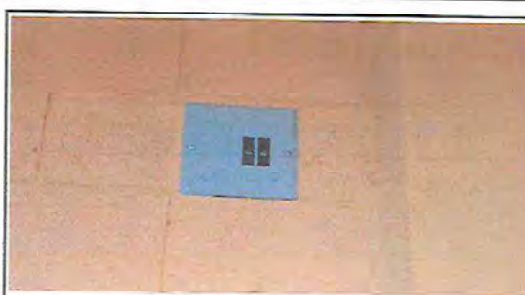
Foto 10: INSTALACIÓN DE TABLERO Y FLIPON
