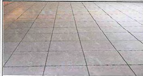
Foto 13: INSTALACION DE PISO CERÁMICO
