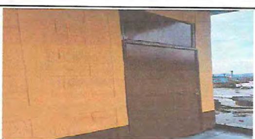
Foto 6: INSTALACIÓN DE PUERTA DE METAL
