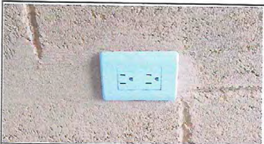
Foto 9: INSTALACIÓN DE UNIDADES DE FUERZA
