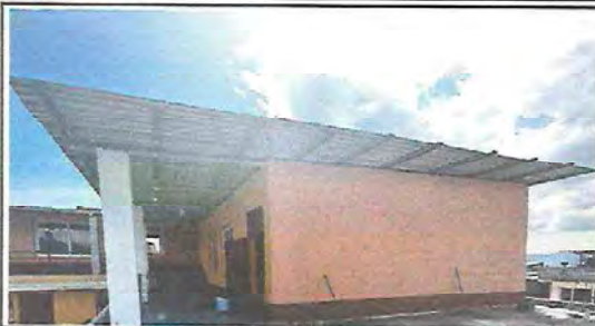
Foto 1: MUROS PERIMETRALES DE COCINA
