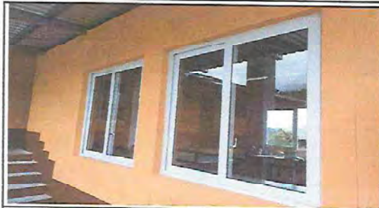
Foto 7: INSTALACIÓN DE VENTANA PVC
