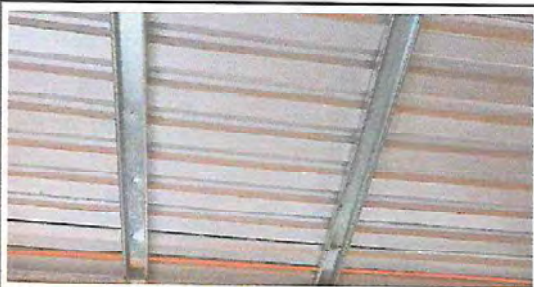
Foto 3: INSTALACIÓN DE LAMINA TROQUELADA ALUZINC
