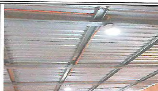
Foto 8: INSTALACIÓN DE UNIDADES DE LUZ
