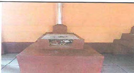
Foto 4: INSTALACIÓN DE ESTUFA RURAL CON CHIMINEA
