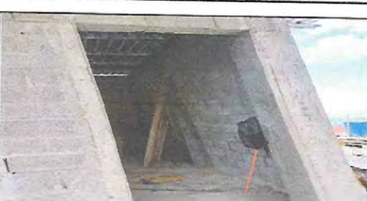
Foto 6: INSTALACIÓN DE PUERTA DE METAL
