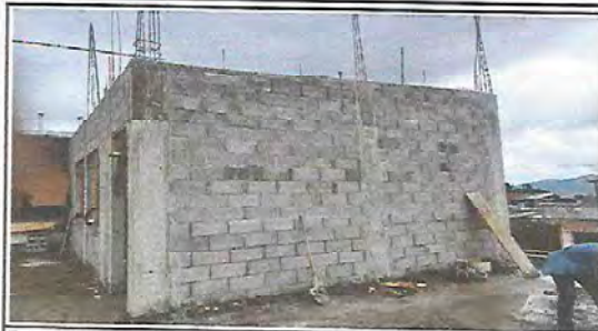
Foto 1: MUROS PERIMETRALES DE COCINA
