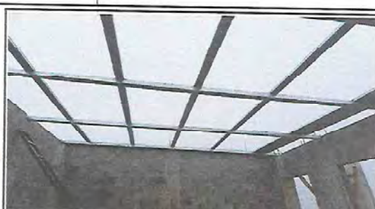
Foto 2: INSTALACIÓN DE ESTRUCTURA PORTANTE DE METAL
