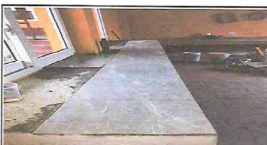
Foto 12: INSTALACIÓN DE CERÁMICA EN MESONES DE CONCRETO
