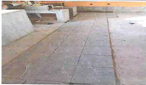
Foto 13: INSTALACIÓN DE PISO CERÁMICO
