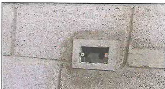
Foto 9: INSTALACIÓN DE UNIDADES DE FUERZA
