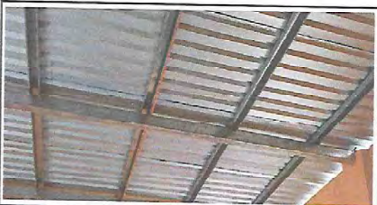
Foto 3: INSTALACIÓN DE LAMINA TROQUELADA ALUZINC
