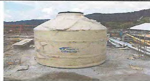
Foto 14: SUSTITUCIÓN DE DEPÓSITO DE AGUA DE 1700 LT
