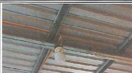
Foto 8: INSTALACIÓN DE UNIDADES DE LUZ
