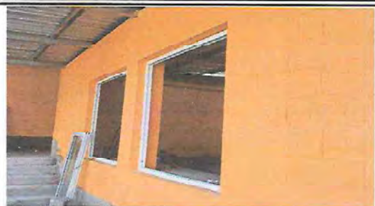
Foto 7: INSTALACIÓN DE VENTANA PVC
