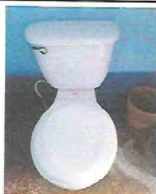
Foto 4.1 Instalación de Inodoros
