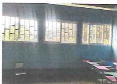
Foto 3.1 Instalación de ventanas PVC de 1 x 1.40
