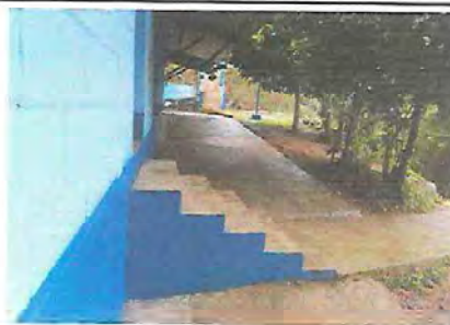
Foto 3.2 Mejoramiento de patio con pavimento
