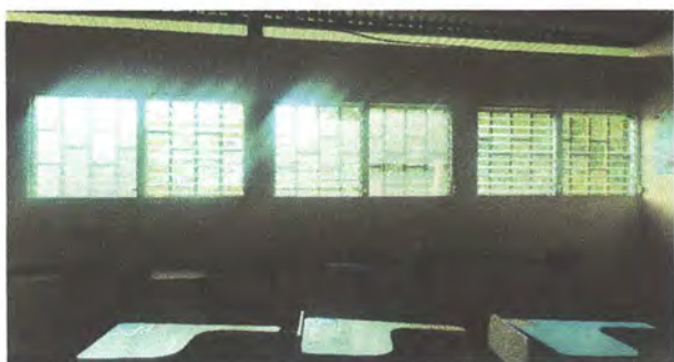
Foto 3.1 Instalación de ventanas PVC de 1 x 1.40
