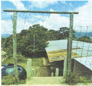
Foto 1.2 Puerta con maya metalica de 2*1
