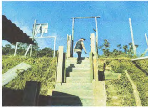
Foto 1.3 Barandal con tubo redondo galvanizado
