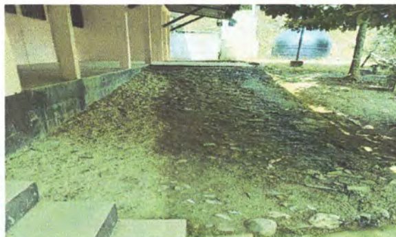
Foto 3.2 Mejoramiento de patio con pavimento
