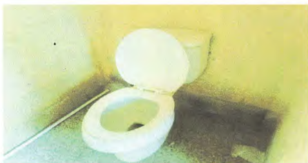
Foto 4.1 Instalación de inodoros
