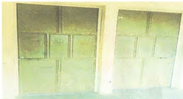
Foto 4.2 Mantenimiento con pintura para puertas
