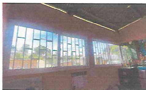
Foto 6: Colocacion de ventanas de CPVC DE 2 X 1 en direccion del INEB
