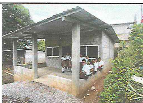
Foto 4: Mejoramiento de cosina y cambio de piso de tierra a piso de cemento.
