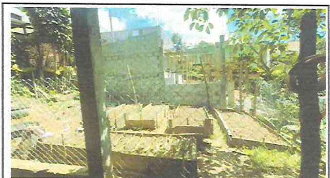
Foto 4: Ampliación de cocina.
