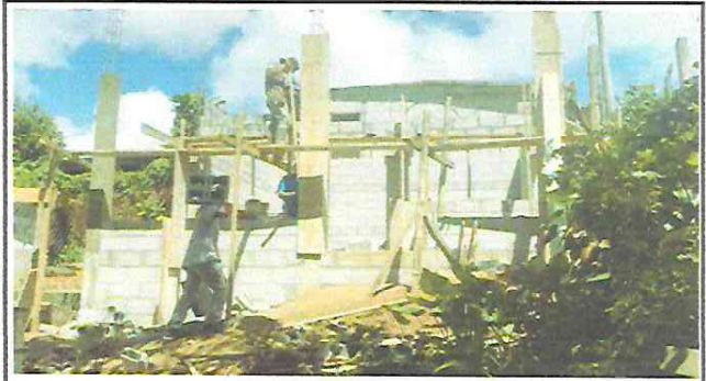
Foto 2: Fundición de los postes del corredor de la cocina.
