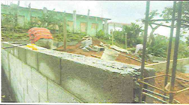
Foto 1: Seguimiento de construcción de la cocina.
