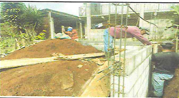
Foto 5: Relleno de terreno para mejoramiento de la cocina.
