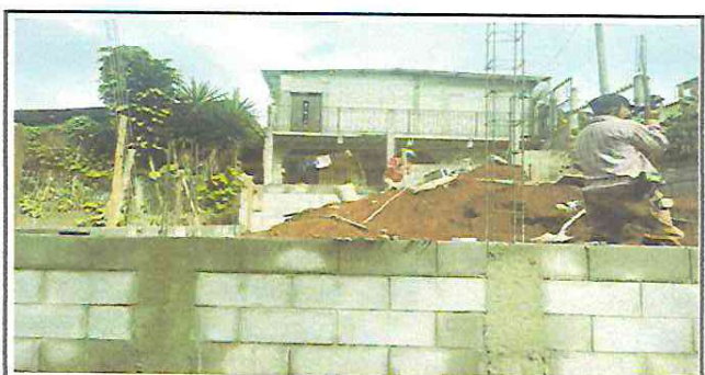
Foto 6: División de cocina y corredor.
