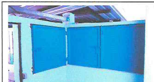
Foto 5: INSTALACION DE VENTANAS DE METAL EN COCINA
