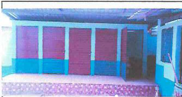
SUSTITUCION DE PISO LIQUIDO POR PISO ANTIDESLIZANTE EN BAÑOS
