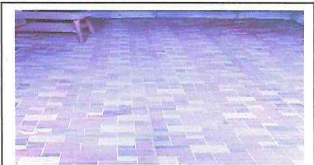
Foto 4: SUSTITUCION DE LAMINA TROQUELADA EN COSINA
