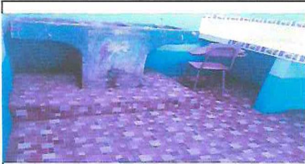
Foto1: SUSTITUCION DE PISO LIQUIDO POR PISO ANTIDESLIZANTE EN COCINA
