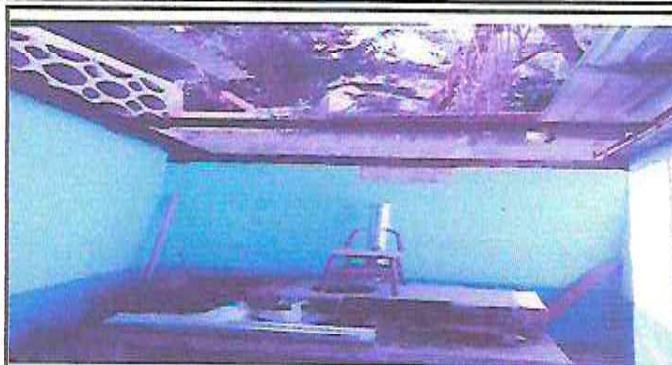
FotSUSTITUCION DE PLANCHA Y CHIMINEA EN COCINA
