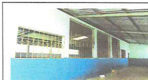
Foto 4: SUMINISTRO E INSTALACIÓN DE VENTANAS DE PVC
