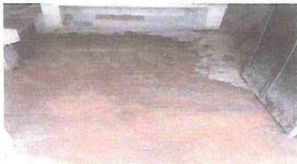
FOTO 1. SUSTITUSION DE PISO LIQUIDO POR PISO ANTIDESLIZANTE EN COCINA.
