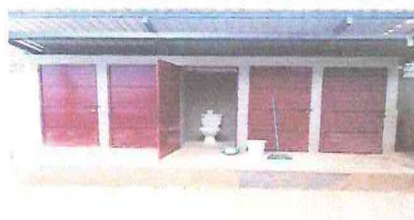
Foto 4: SUSTITUCION DE PISO LIQUIDO POR PISO ANTIDESLIZANTE EN BAÑOS.
