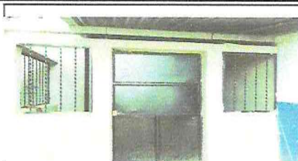
Foto 2: MANTENIMIENTO DE PUERTA
