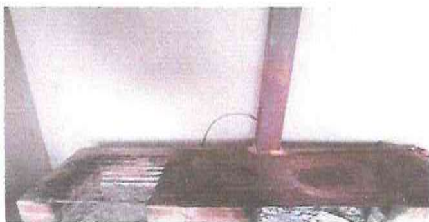
FOTO 3. SUSTITUCION DE CHIMINEA DE METAL POR METAL Y PLANCHA DE COCINA.
