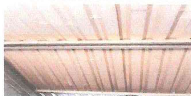
SUSTITUCION DE LAMINA POR LAMINA TROQUELADA Y SOPORTE METALICO.
