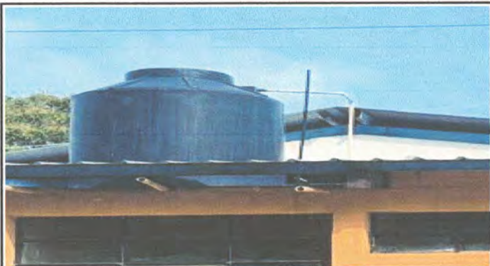
Foto 7.1 Sustitución de depósito de agua de (1,100 litros)
