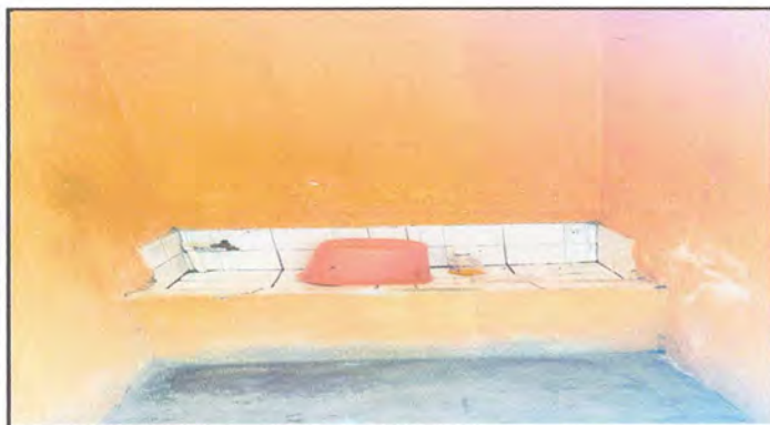
Foto 9.2 Sustitución de pila de un lavadero.
