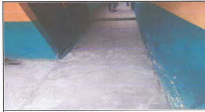
Foto 6.1 Reparación de banqueta de concreto.
