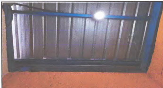
Foto 1.1 Sustitución de lámina troquelada Aluzinc calibre 26.
