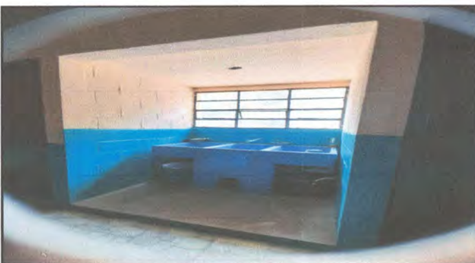
Foto 9.1 Sustitución de pila de dos lavaderos.
