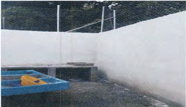
Foto1: Reparación de muro perimetral de Block y sernido en muro
