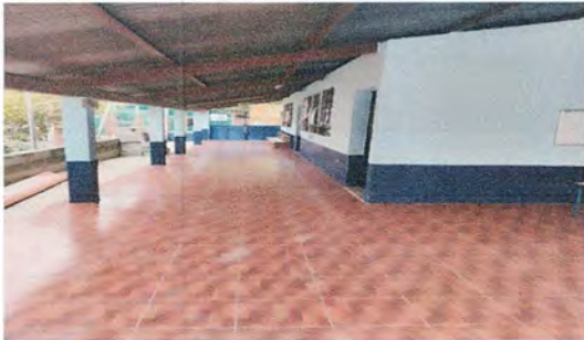
Foto 5: Sustitución de piso de cemento líquido por piso cerámico
