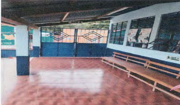
Foto 2 Sustitución de portón de metal de ingreso.
