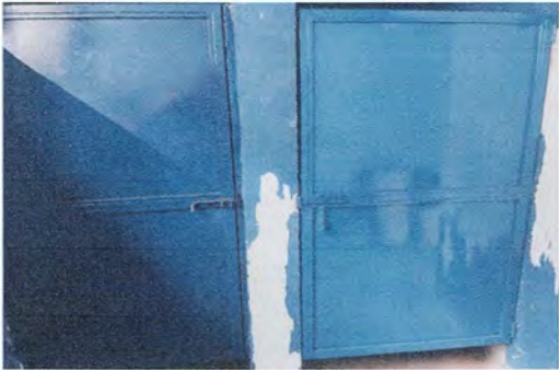
Foto 8 sustitución de puerta de baño.
