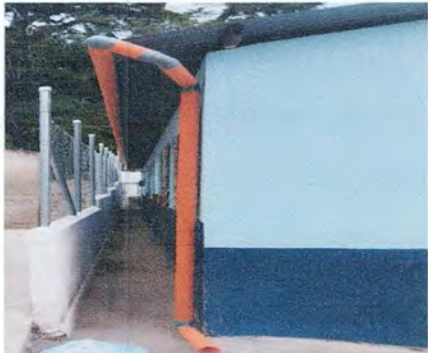
Foto 3: Cernido en muro perimetral y reparación de muro con tubo HG y malla galvanizada.
