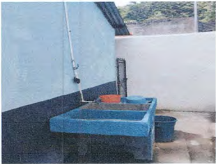
Foto7: Sustitución de pila de cemento de dos lavaderos
