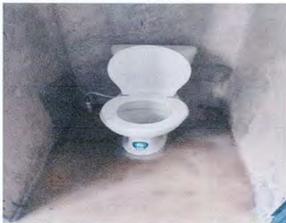
Foto 6: Sustitución de Sanitario
