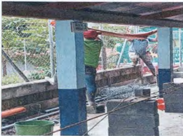
Foto 4: Sustitución de canal de PVC.
