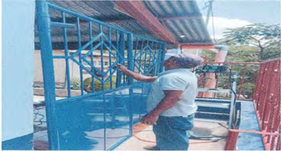
Foto 2 Sustitución de portón de metal de ingreso.
