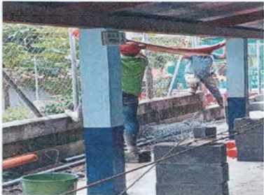
Foto 4: Sustitución de canal de PVC.
