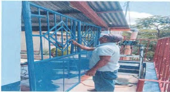
Foto 2 Sustitución de portón de metal de ingreso.
