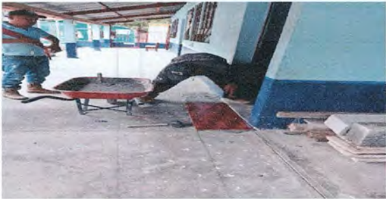
Foto 5: Sustitución de piso de cemento líquido por piso cerámico
