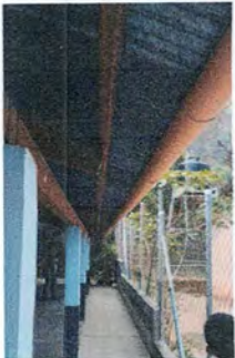
sustitución de canal de PVC
