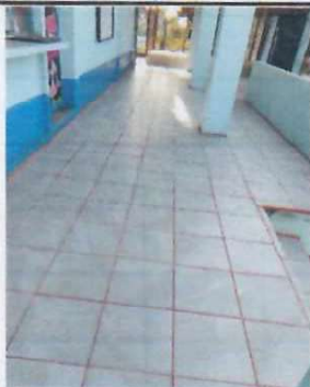
Foto 1: Reparación de Piso, Sustitución de piso de concreto por piso cerámico, en área de corredor con losa.
