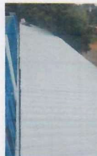
Foto 4: Reparación de Techo en mal estado y se sustituyó por Lámina Aluzinc Troquelada Calibre 26 Legítima
