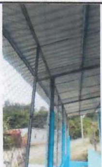
Foto 5: Reparación de Techo en mal estado y se sustituyó por Lámina Aluzinc Troquelada Calibre 26 Legítima. Y sustitución de Malla Galvanizada y Tubo HG.
