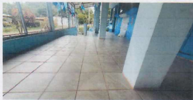
Foto 2: Sustitución de piso de concreto por piso cerámico, en área de corredor con losa. Y cambio de cubierta provisional a Cubierta de Techo con costanera y Lámina Aluzinc Troquelada Calibre 26 Legítima
