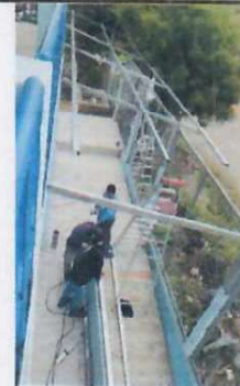
Foto 4: Reparación de Techo en mal estado y se sustituirá por Lámina Aluzinc Troquelada Calibre 26 Legítima.
