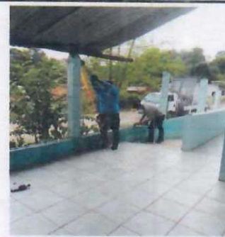
Foto 6: Reparación de Muro perimetral Sustitución de Malla Galvanizada y Tubo HG., Cuneta peatonal y Banqueta en Muro Frontal
