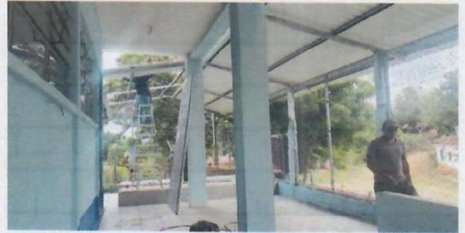
Foto 2: Sustitución de piso de concreto por piso cerámico, en área de corredor con losa. Y cambio de cubierta provisional a Cubierta de Techo con costanera y Lámina Aluzinc Troquelada Calibre 26 Legítima.
