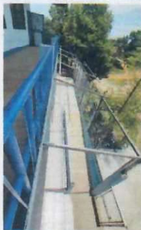
Foto 5: Reparación de Techo en mal estado y se sustituirá por Lámina Aluzinc Troquelada Calibre 26 Legítima. Y Sustitución de Malla Galvanizada y tubo HG.
