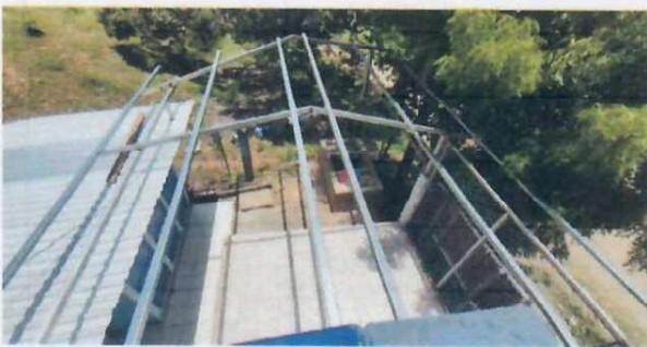
Foto 3: Reparación de Techo en Área de Pila se cambiará cubierta provisional a Cubierta de Techo con costanera y Lámina Aluzinc Troquelada Calibre 26 Legítima.
