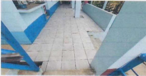
Foto1: Reparación de piso, sustitución de piso de concreto por piso cerámico, en área de corredor de losa.
