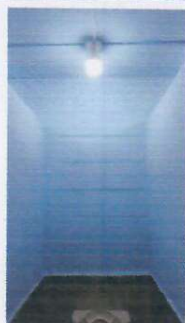
Foto 3: Reparación de servicio sanitario para niños y niñas.
