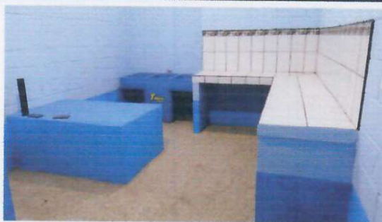
Foto 5: Reparación de cocina y reparación de sistema eléctrico, plafonera, foco, flexitubo, abrazaderas, tomacorrientes e interruptores.
