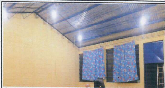
Foto1: Reparación de sistema eléctrico, plafonera, foco, flexitubo, abrazaderas, tomacorrientes e interruptores.
