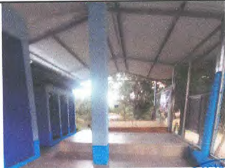
Foto 11: Readecuación de Sistema de Luminarias para Escenario.
