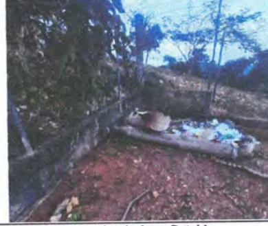
Foto 8: Reubicación de Deposito de Agua Potable.
