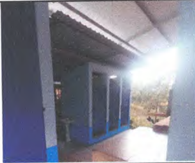
Foto 9: Reparación Techo de Cocina, Incluye Levantado de Columna Metalica, Levantado y Reinstalación de Costaneras y Lamina Troquelada calibre 26 existente en buen estado e Iluminación.
