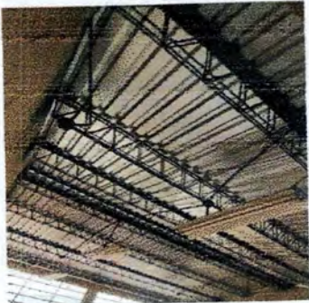
Foto 2: Techo del aula
