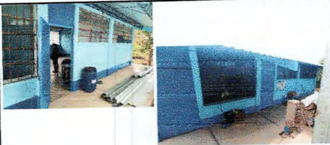
Foto 3: Aplicación de pintura del las paredes del aula
