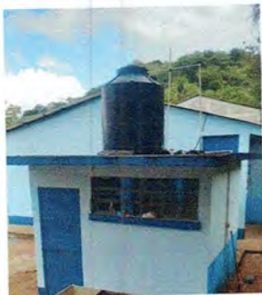
Foto7: Terminación de servicios sanitarios. Aplicación de pintura para interiores y exteriores.
