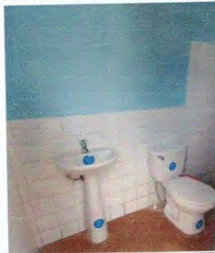
Foto 8: Terminación de servicios sanitarios, cambio de inodoro y lavamanos.
