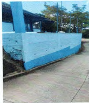
Foto 10: Terminación de muro perimetral, aplicación de pintura para interior y exterior.
