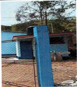
Foto7: Proceso de servicios de sanitarios, aplicación de pintura para interiores y exteriores
