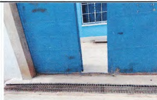
Foto 6: Reparación de cuneta de concreto
