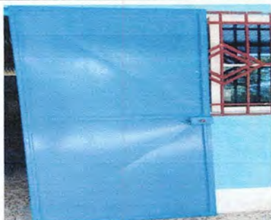
Foto 3: Sustitución de chapa de puerta
