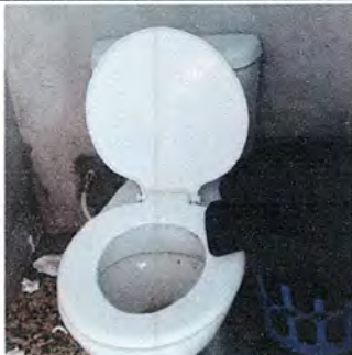
Foto1: SUSTITUCIÓN E INSTALCIÓN DE INODOROS
