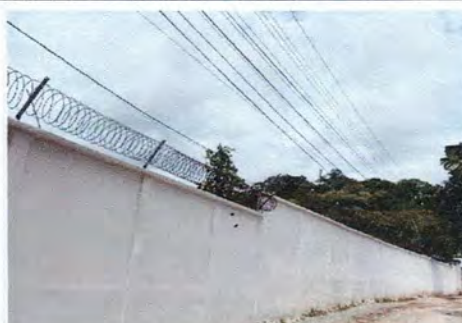
Foto 2: Reparación de muro perimetral de block. (repello)
