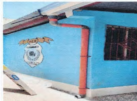
Foto 4: Sustitución de bajada de agua pluvial de metal por tubo PVC 3"
