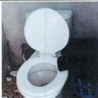
Foto1: SUSTITUCIÓN E INSTALCIÓN DE INODOROS
