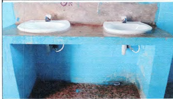
Foto 8: SUSTITUCIÓN INSTALACIÓN DE LAVA MANOS
