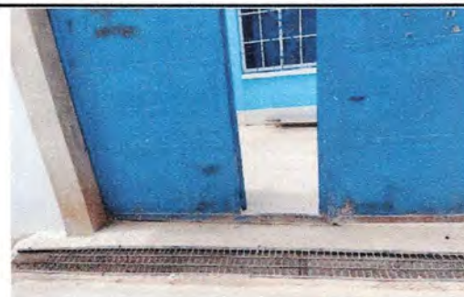
Foto 6: Reparación de cuneta de concreto
