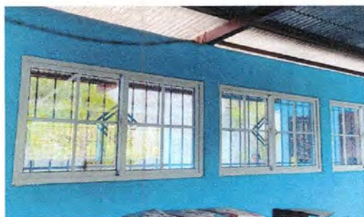
Foto 5: SUSTITUCIÓN O INSTALCIÓN DE VENTANAS DE MADERA POR PVC
