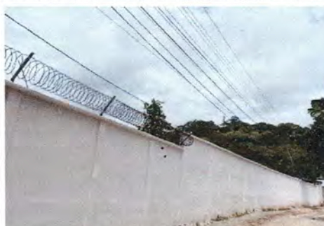
Foto 2: Reparación de muro perimetral de block. (repello)
