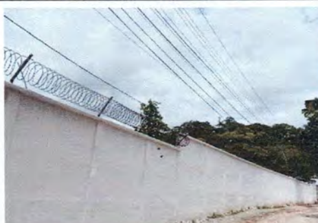
Foto 2: Reparación de muro perimetral de block. (repello)
