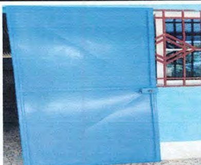
Foto 3: Sustitución de chapa de puerta
