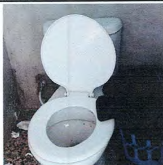
Foto1: SUSTITUCIÓN E INSTALCIÓN DE INODOROS
