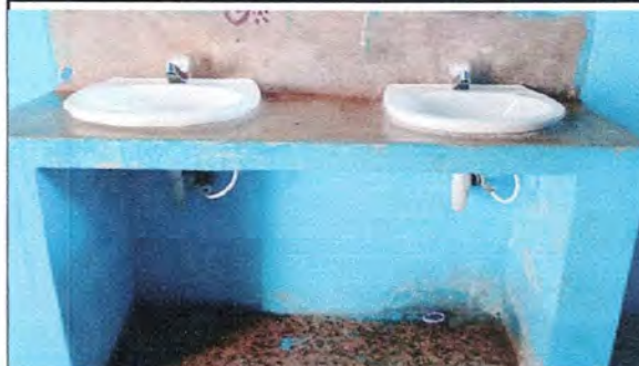
Foto 8: SUSTITUCIÓN INSTALACIÓN DE LAVA MANOS
