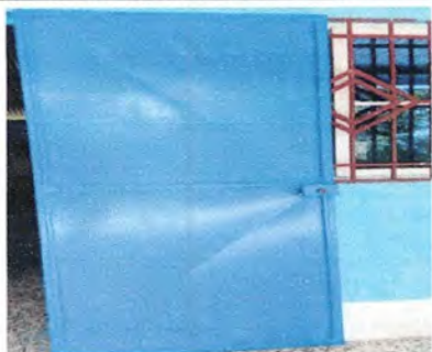
Foto 3: Sustitución de chapa de puerta
