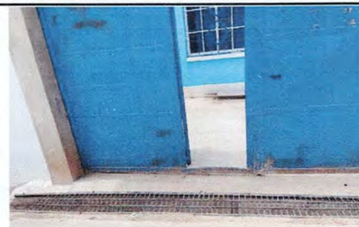
Foto 6: Reparación de cuneta de concreto
