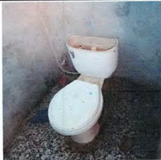
Foto1: SUSTITUCIÓN E INSTALCIÓN DE INODOROS
