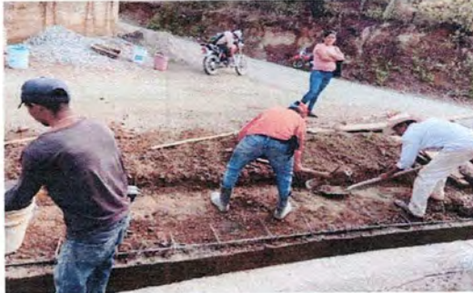
Foto7: Reparación de cuneta de concreto
