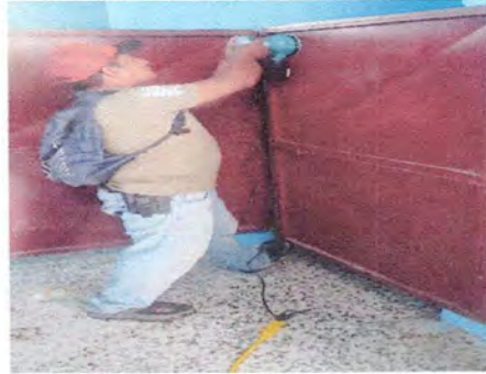
Foto 8: Mantenimiento a estructura (lijado, cambio de tubo , cepillado, sujeciones, aplicación de pintura)
