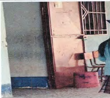
Foto 3: Sustitución de chapa de puerta
