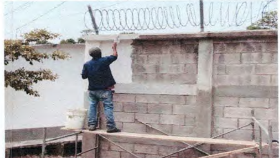
Foto 2: Reparación de muro perimetral de block. (repello)
