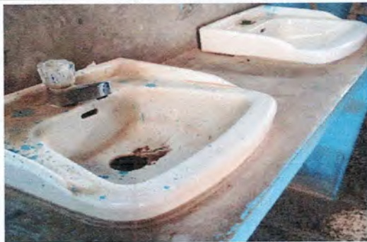
Foto 9: SUSTITUCIÓN INSTALACIÓN DE LAVA MANOS
