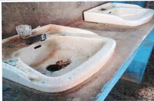
Foto 9: SUSTITUCIÓN INSTALACIÓN DE LAVA MANOS
