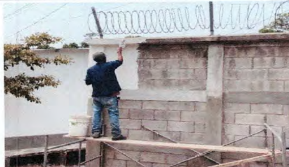
Foto 2: Reparación de muro perimetral de block. (repello)
