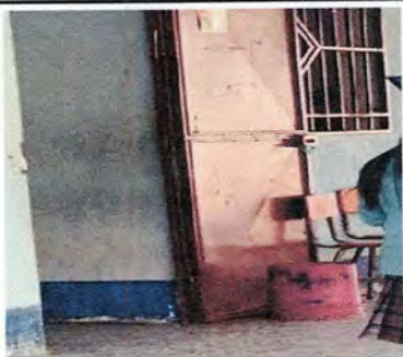
Foto 3: Sustitución de chapa de puerta
