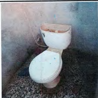
Foto1: SUSTITUCIÓN E INSTALCIÓN DE INODOROS
