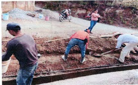
Foto7: Reparación de cuneta de concreto
