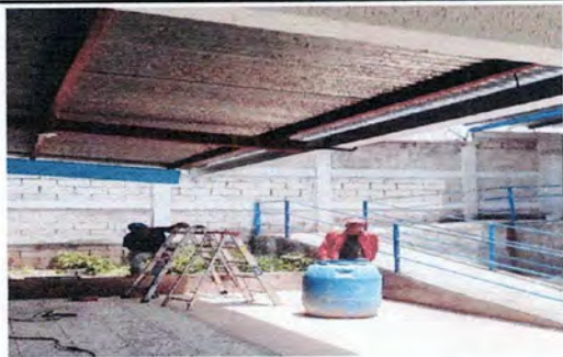
Foto 5: Sustitución de bajada de agua pluvial de metal por tubo PVC 3"
