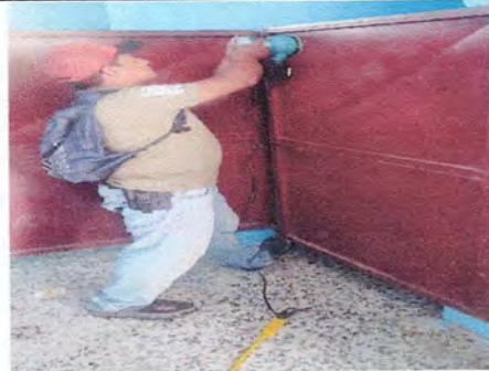
Foto 8: Mantenimiento a estructura (lijado, cambio de tubo , cepillado, sujeciones, aplicación de pintura)
