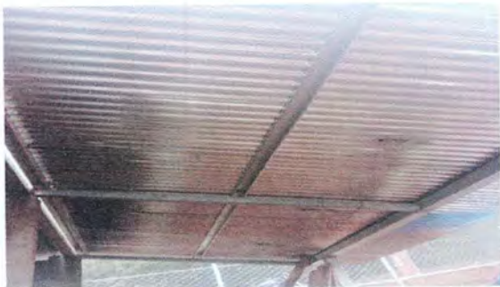
Foto 1: Sustitución de lámina de galera exterior
