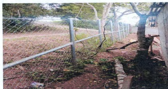
Foto 12: Sustitución de alambre de púa por tubo y malla galvanizada
