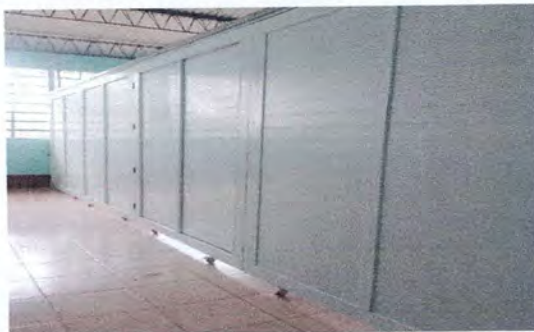
Foto 14: Instalación de división de aula
