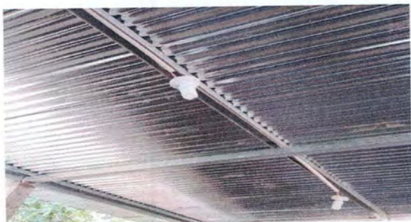
Foto 7: Instalación de cableado eléctrico y bombillas
