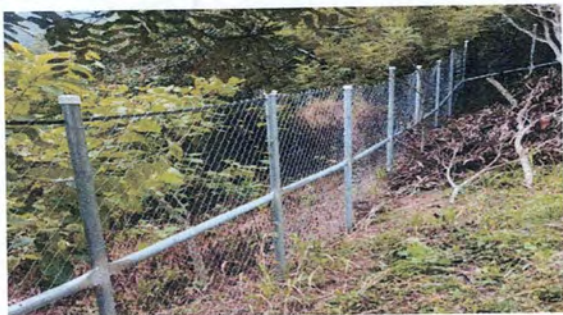
Foto 13: Instalación de muro perimetral de tubo y malla galvanizada
