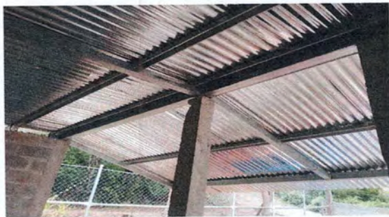
Foto 3: Sustitución de estructura de soporte de madera por estructura de metal
