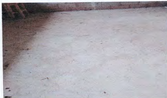
Foto 8: Instalación de piso de torta
