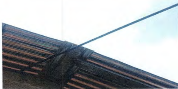
Foto 5: Sustitución de cable eléctrico
