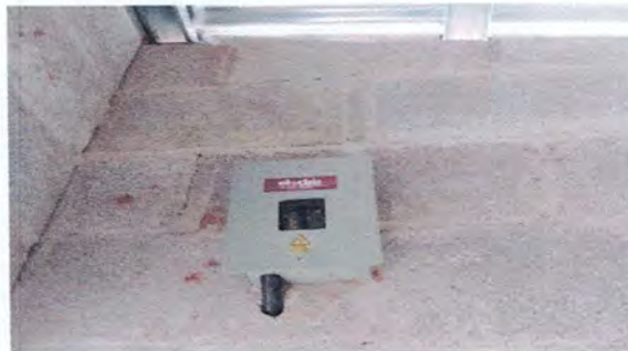
Foto 4: Reparación de caja eléctrica
