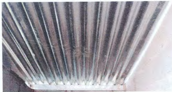
Foto 2: Sustitución de lámina
