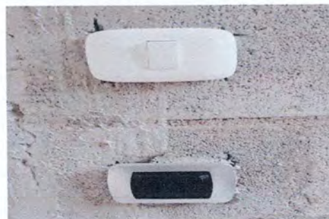
Foto 6: Instalación de tomacorriente y apagador
