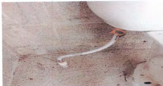
Foto 11: Instalación de drenaje para sanitario
