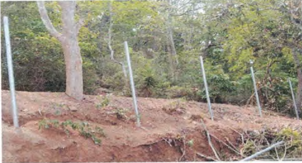
Foto13: Instalación de tubos hg, del muro perimetral
