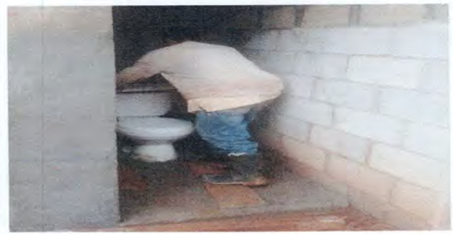
Foto 10: Instalación de servicio sanitario
