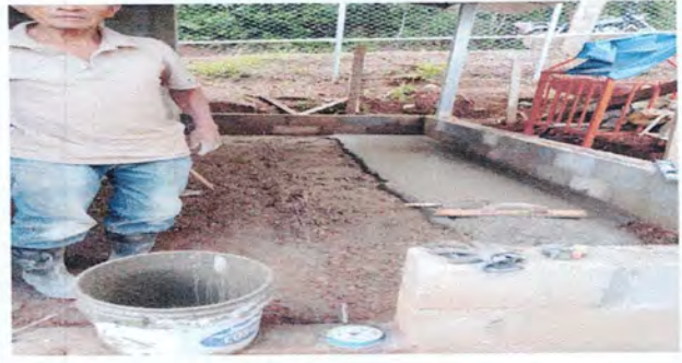
Foto 8: Fabricación de piso de torta
