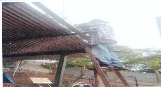
Foto 3: Instalación de estructura metálica en galera exterior
