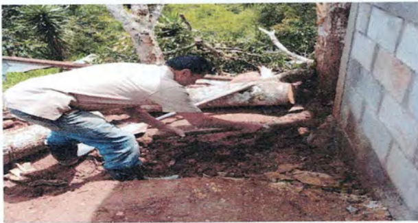
Foto 11: Instalación de drenaje para sanitario
