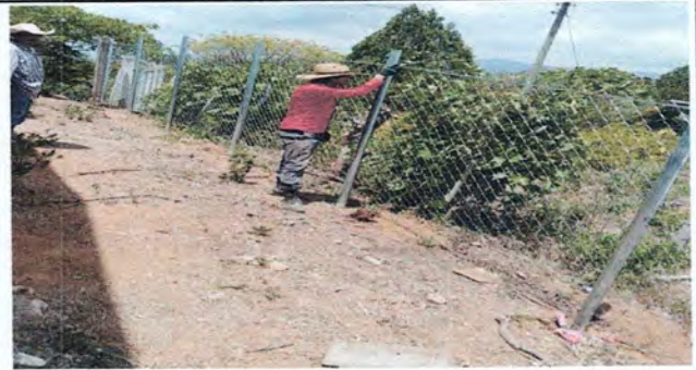
Foto 14: Instalación de malla galvanizada
