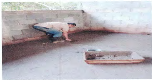
Foto 9: Instalación del piso
