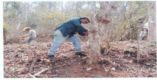
Foto 12: Limpieza del área del muro perimetral
