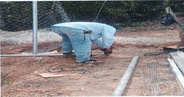
Foto 15: Soldando malla galvanizada al tubo hg
