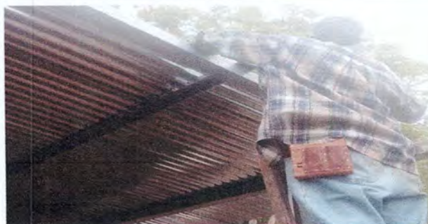
Foto 4: Instalación de cableado eléctrico
