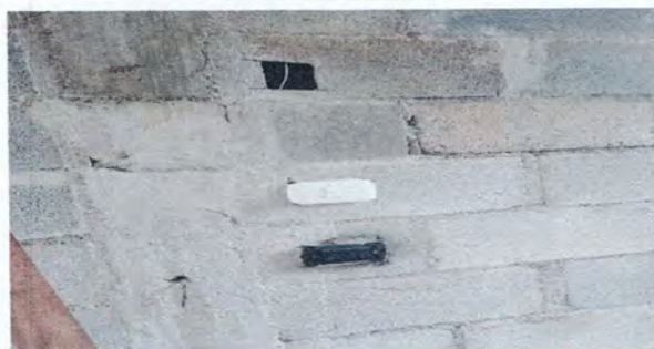
Foto 6: Instalación de tomacorrientes en galera exterior
