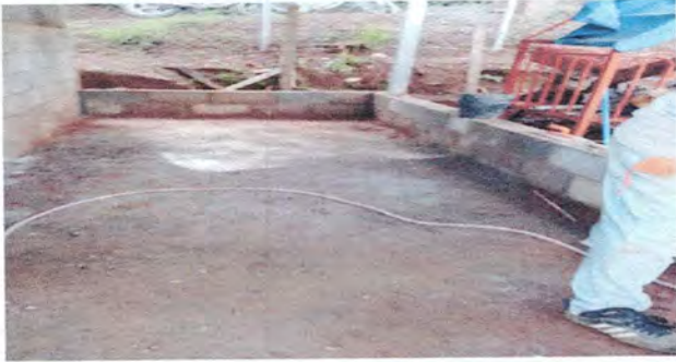
Foto 7: Preparación del área para instalar el piso de torta
