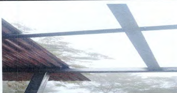
Foto 2 : Instalación de estructura de soporte de madera por estructura de soporte de metal
