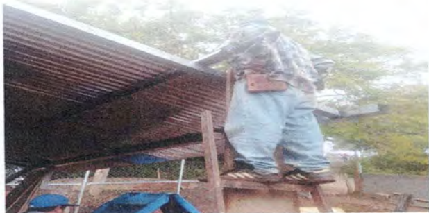
Foto 1: Sustitución de lámina en galera exterior
