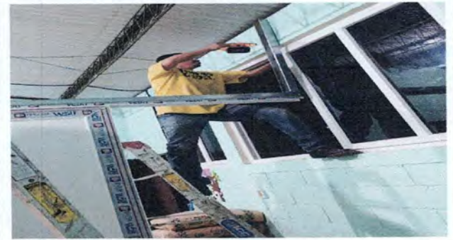
Foto 16: : Instalación de soporte de metal para división del aula
