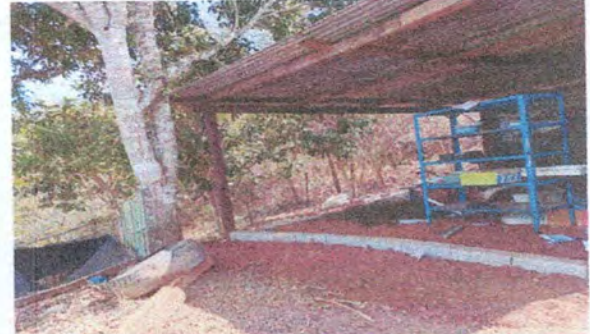
2. sustitucion de soporte de madera por metal
