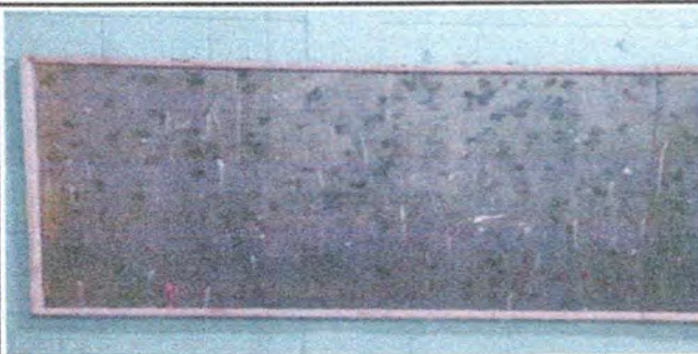
11. Reparación de pizarrón de madera e instalación de formica
