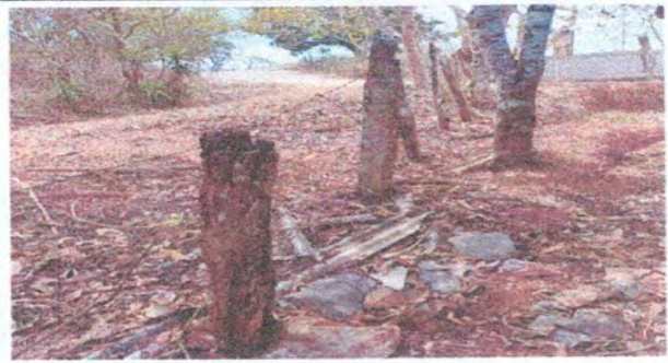
8. sustitución de alambre de pua por malla con tubo galvanizado
