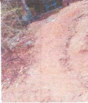
7. drenaje de baños
