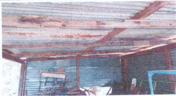
1. Sustitucion de lamina, por lamina troquelada
